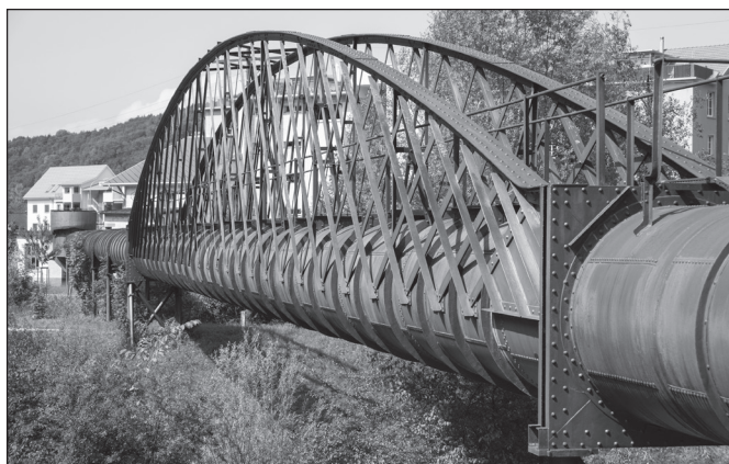
Der Röhrenaquädukt des Tössgewerbekanal bei Kollbrunn führt das Wasser des Kanals in einer Druckleitung über die Töss. Foto Cornel Doswald 2009
