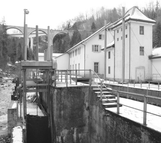
Kraftwerk Lorzentobel, Baar, Foto H. Gervasi 2019
