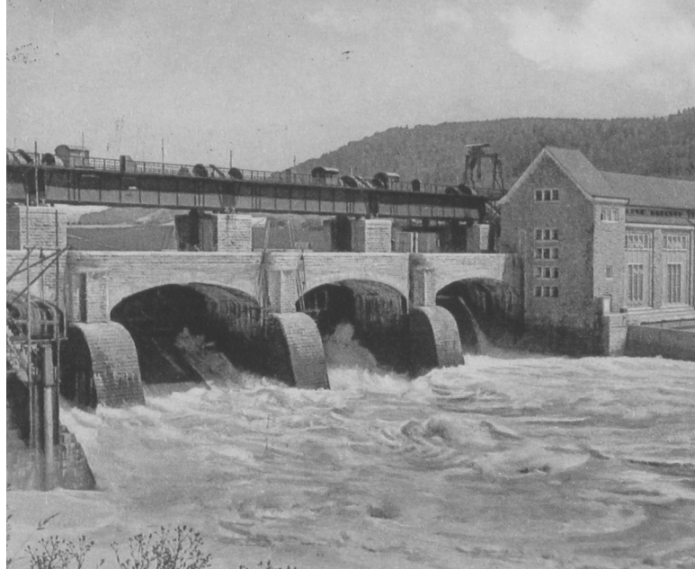
Postkarte Flusskraftwerk Laufenburg von 1918, e-pics.ethz.ch
