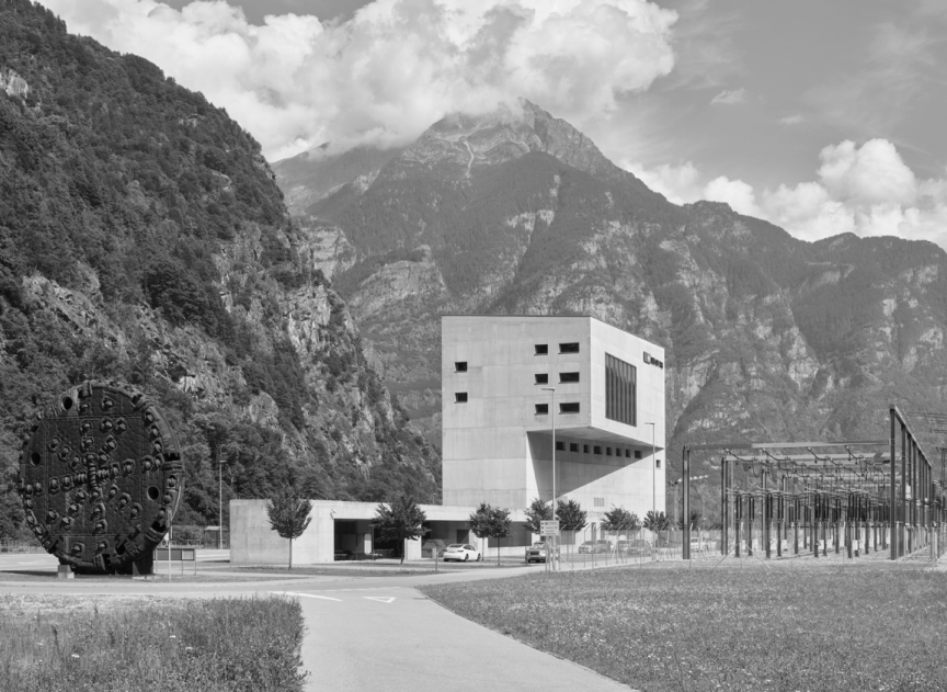
Betriebszentrale Süd (Pollegio), Foto: Tonatiuh Ambrosetti
