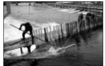
Das Nadelwehr muss bei Hochwasser mit Muskelkraft «Zäppi für Zäppi» geöffnet werden – eine gefährliche Arbeit.
