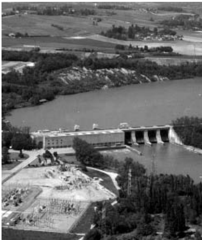
Centrale de Verbois Kraftwerk Verbois
