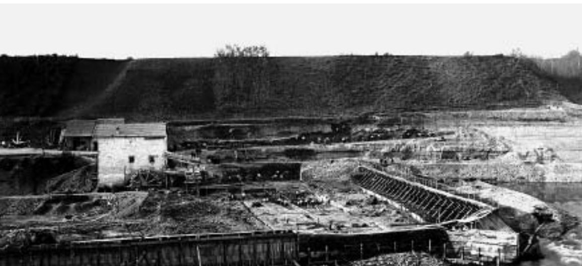
Chantier de l'usine de Chèvres avec le vieux moulin Baustelle des Kraftwerkes Chèvres mit der alten Mühle
